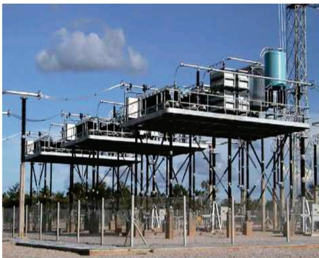
Рис. 1. Пример устройства продольной компенсации.[1]
