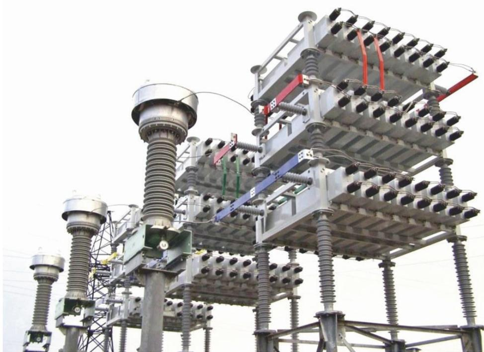
Рис. 1. Внешний вид батареи статических конденсаторов. [1]
